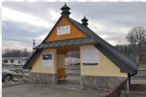
Budowa wiaty (altany turystycznej) w miejscowości Iwkowa
