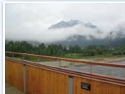
Kładka na rzece Dunajec Gmina Czorsztyn Lávka cez rieku Dunajec, gmina Czorsztyn
